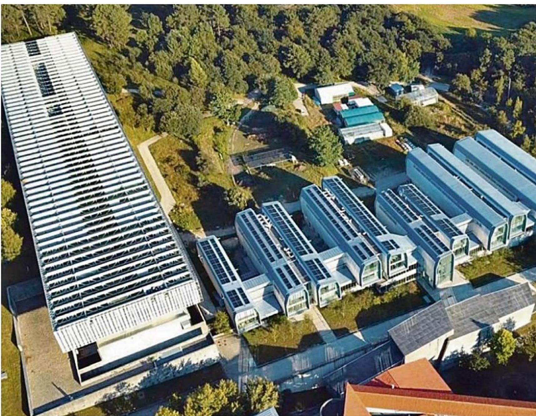
Vista aérea del CACTI, en el campus de Vigo, con varias instalaciones fotovoltaicas.
